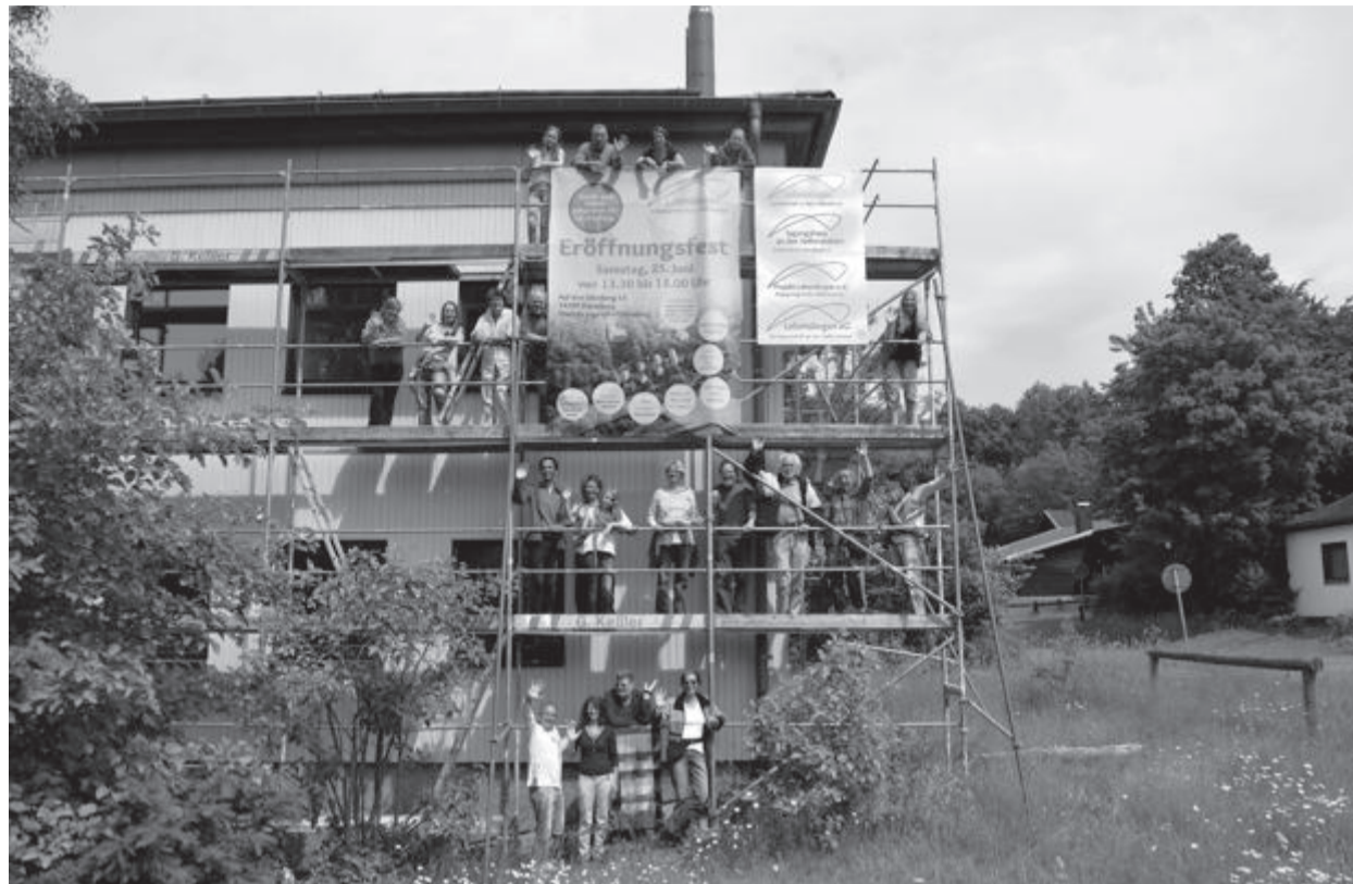
▲ Mit frisch gestrichener Fassade kurz vor dem offiziellen Eröffnungsfest (Juni 2016) ein Jahr nach Einzug
